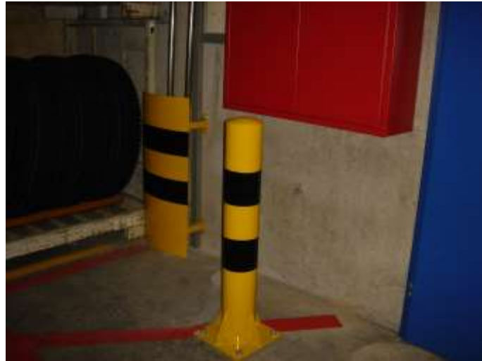
Abbildung Schutzverkleidung Leitungen und Pfosten vor Löscherät und Pneugestell
