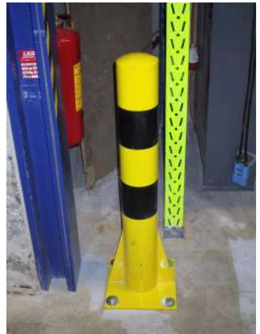
Abbildung Pfosten vor Löscherät und Gestell
